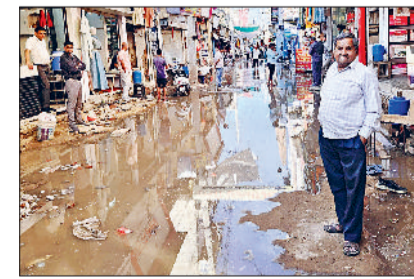
नारनौल। मुख्य बाजार में तोड़ी गई सड़क पर बहता पानी।
